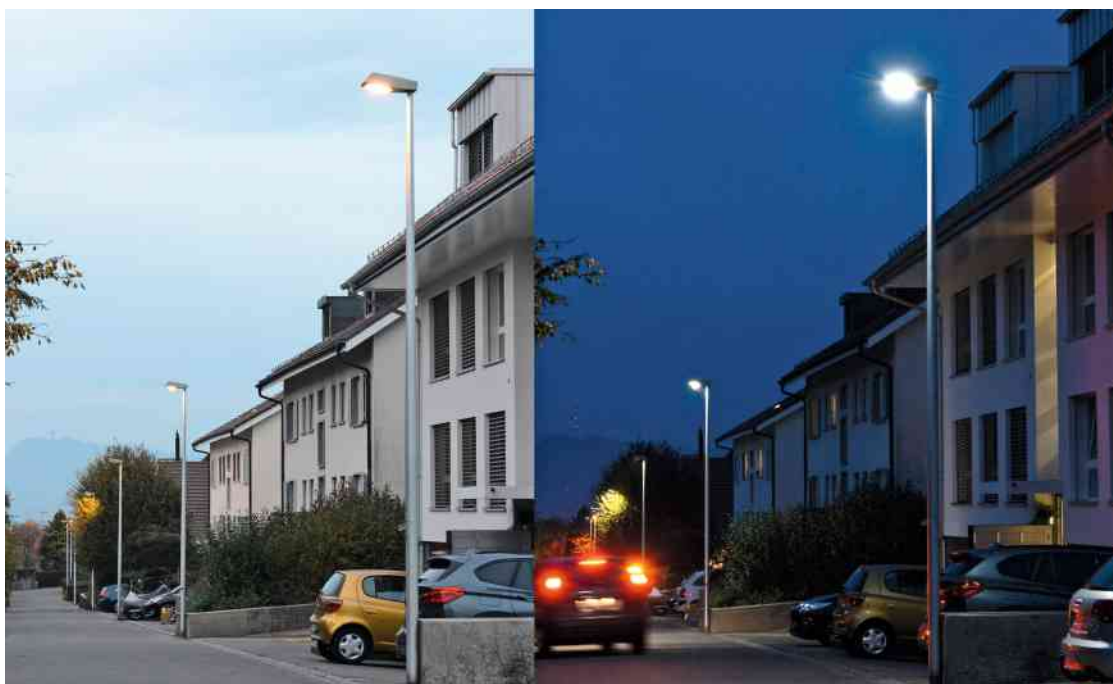
Blick in den Kastanienweg des Wohnquartiers Spiegel der Gemeinde Köniz am 26.10.18 um 18.28 und 18.54 Uhr: Hier erstrahlen die neuen LCC «Street-Lampen» mit 4000 K. Ganz hinten sieht man noch eine alte, orange Beleuchtung mit Natriumdampf-Hochdrucklampe. (Bilder: Markus Frutig, ET Licht)
