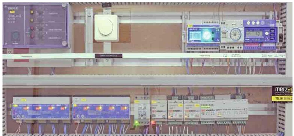
Schaltschrank im EG: LCC-Technologie führt, neben der Kompatibilität mit den se-Lightmanagement UDK Dimm-Modulen, zu optimalen Ergebnissen.
