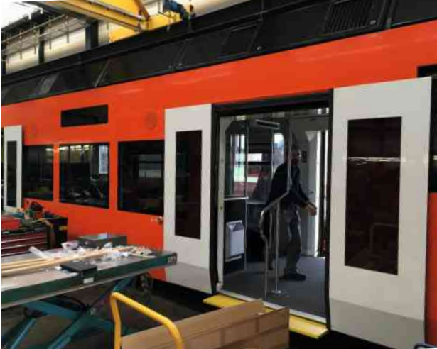
Montage der neuen LCC-Leuchtmittel durch die Techniker des RBS (Bild: D. Geissmann)
