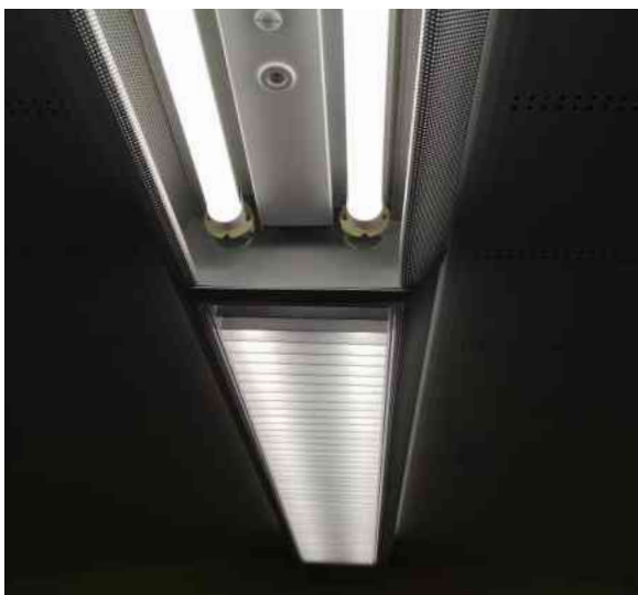
Innenraum der «Seconda» (rechts) mit den neuen LCC-Rohrleuchten T8 (4000K, Detail links). (Bilder: Daniel Geissmann)
